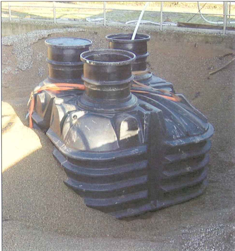
Bild 3: Behälter in Prüfgrube bei Einbau
