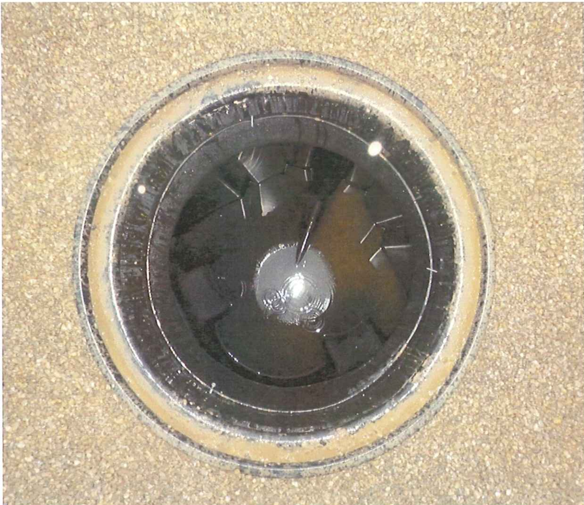
Bild 5: Blick in den leeren Behälter, Prüfung auf Undichtigkeiten und Materialversagen (am Boden Restwasser vom zweiten Auslitern)
