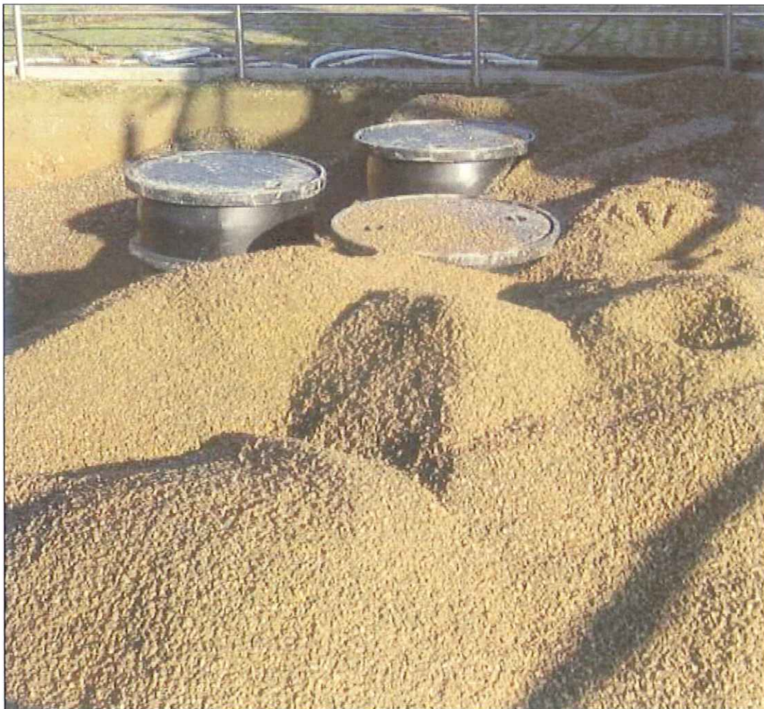
Bild 4: Teilweise eingeschütteter Behälter
